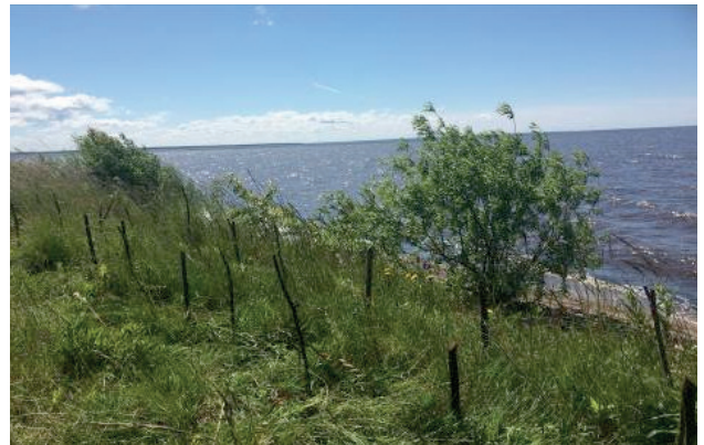
Рисунок 2.3.14 – Биологическое укрепление берегов Рыбинского водохранилища, подверженных переработке и эрозии почв (Пошехонский район, н.п. Федорково), в 2018 г.
