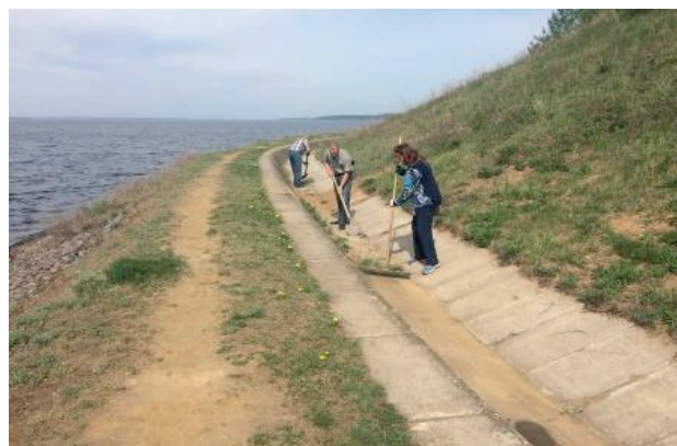
Рисунок 2.3.18 – Очистка ливнеотводящей канавы на территории, прилегающей к ГТС «Ивановское» (Рыбинское водохранилище) в 2018 г.
