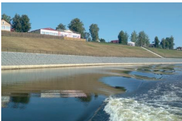
Рисунок 2.3.17 – Берегоукрепление в г. Мышкин (Рыбинское водохранилище) в 2018 г.
